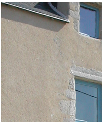
enduit affleurant les pierres d'encadrement
