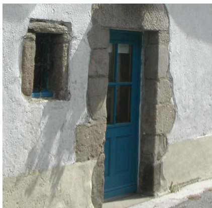
badigeon de chaux et encadrement pierres
