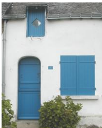
façade entièrement badigeonnée
